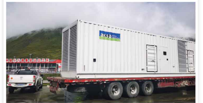
川藏铁路项目
