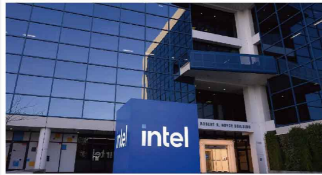
马来西亚英特尔PELICAN数据中心项目
