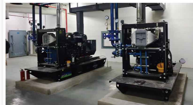
浙江大学邵逸夫医院项目
